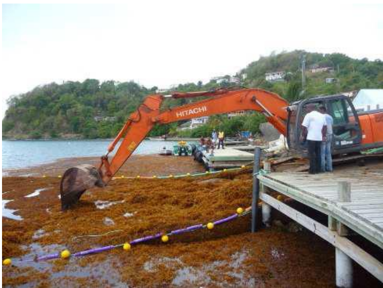
Filet tracté par une pelle mécanique Entreprise DNS (Martinique)
