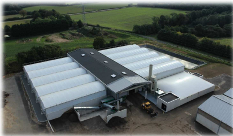
Figure 9 : Exemple de l'unité de compostage d'algues vertes du Pays Fouesnantais
